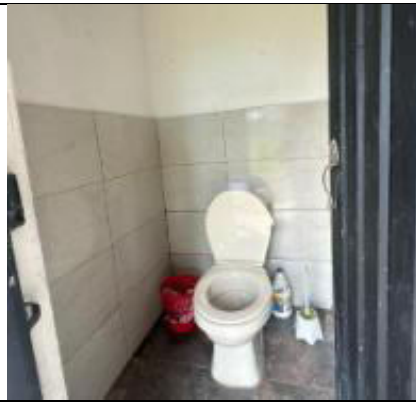
C6. Vista Construcción Interna
