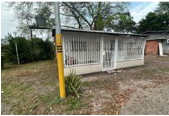
C3. Vista Construcción 3
