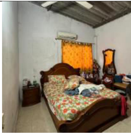
C4. Vista Construcción Interna
