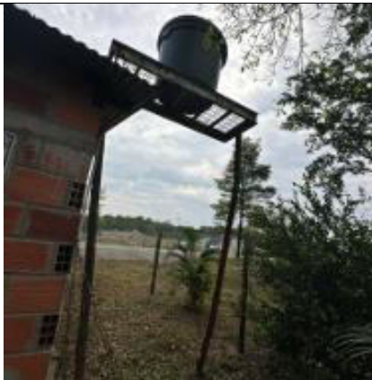
CA17. Estructura para Tanque
