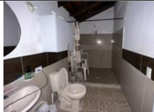
C2. Vista Construcción Interna
