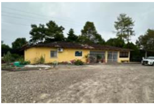
C2. Vista Construcción 2
