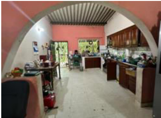
C4. Vista Construcción Interna
