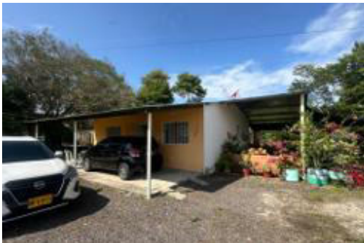
C1. Vista Construcción 1
