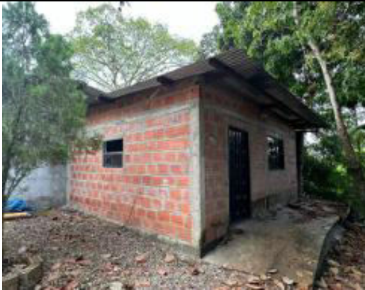
C7. Vista Construcción 7
