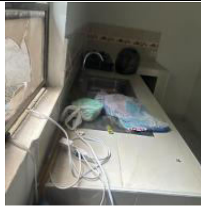
C7. Vista Construcción Interna
