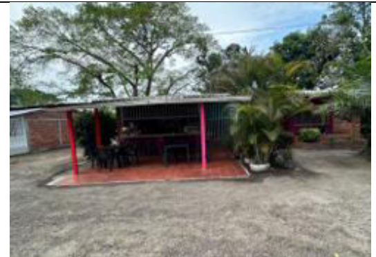
C4. Vista Construcción 4
