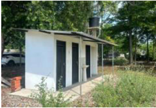
C6. Vista Construcción 6 – Zona de Baños
