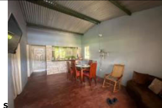
C1. Vista Construcción 1 Interna
